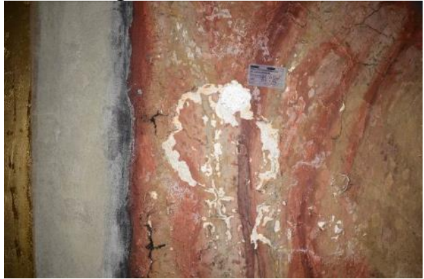
Foto: Pérdida de policromía, Restauratorenteam SL
