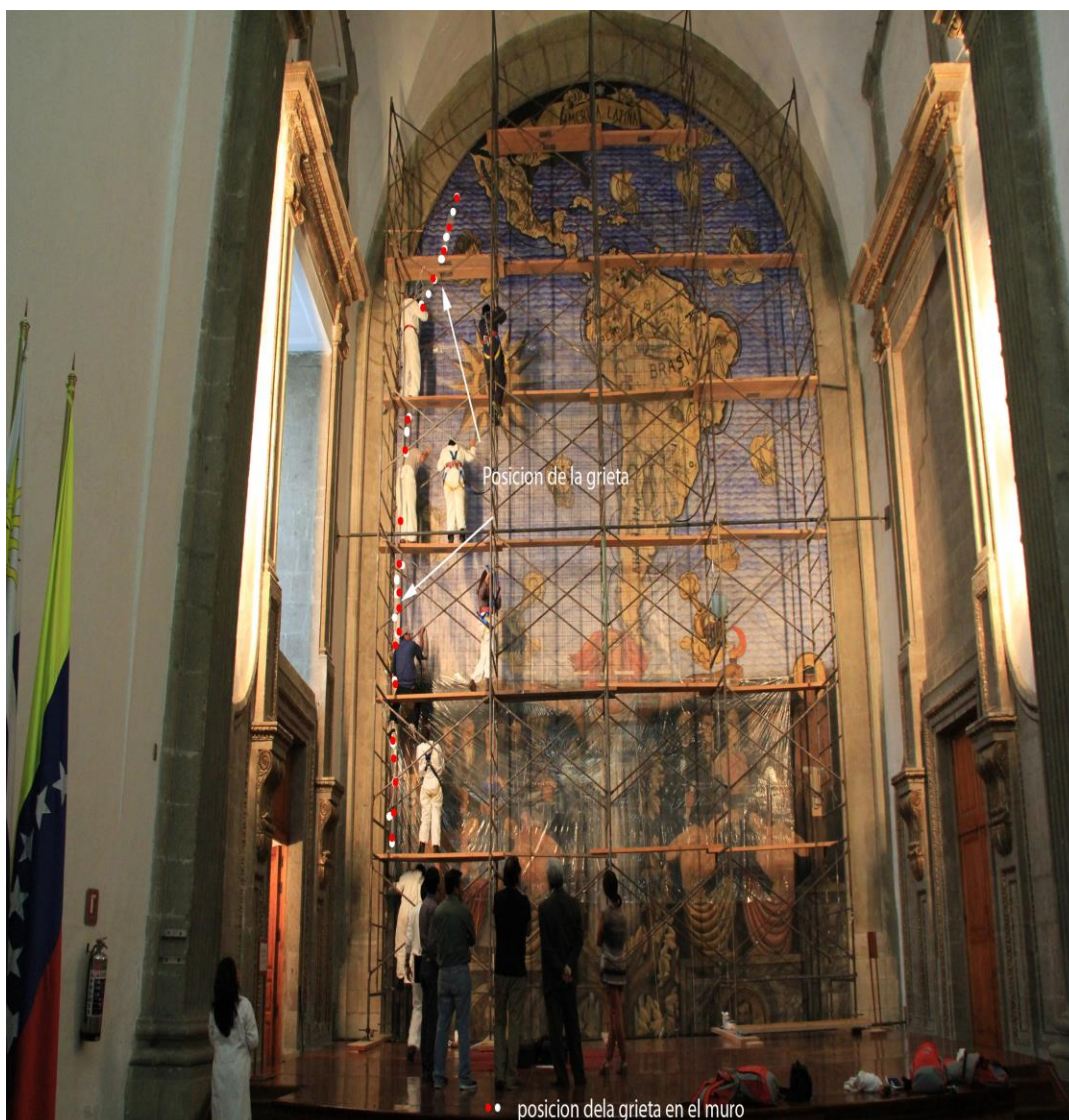
Figura nº1 - Mural «La Unión de América Latina ». Los puntos rojos y blancos señalan la fractura visible en superficie.
