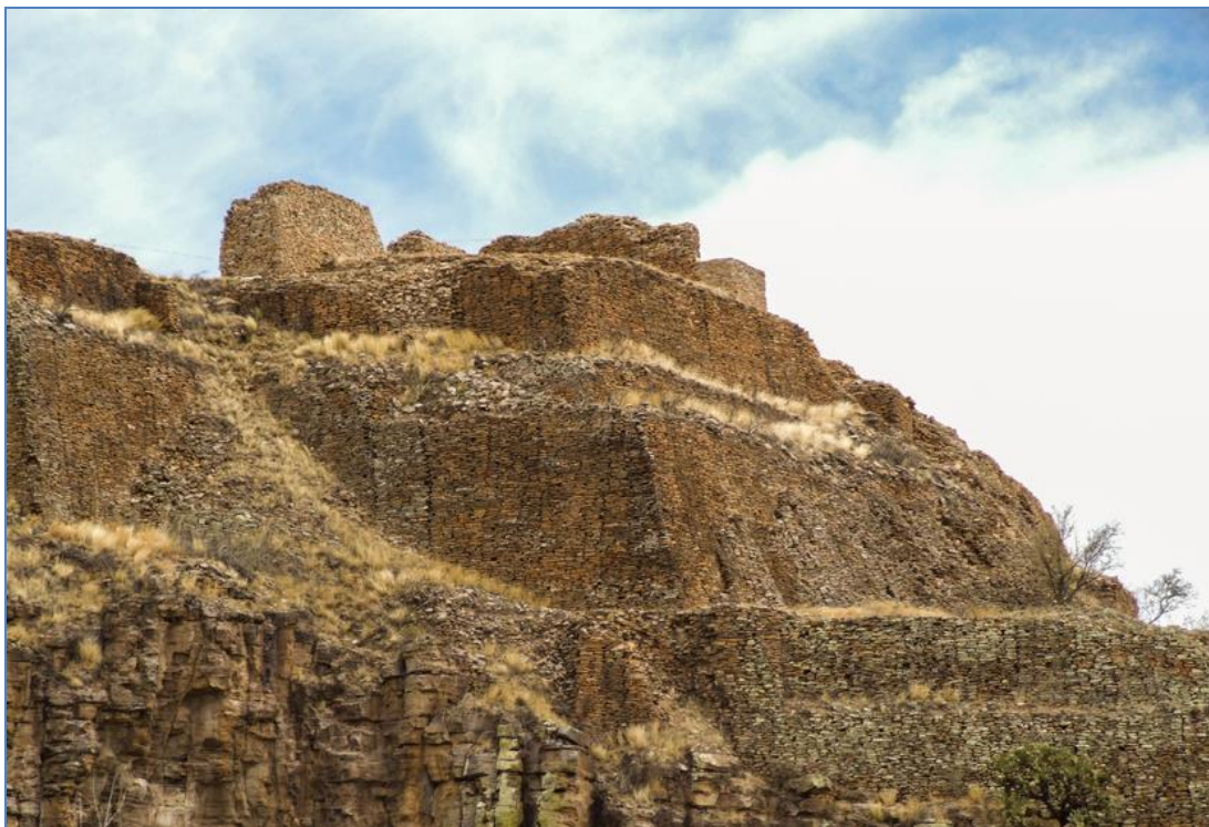
Figura 5 – Vista del lado este de los edificios de La Quemada
